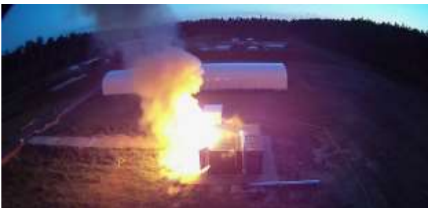
Abbildung 5 Thermisches Durchgehen durch Überladen eines 6,85kWh-Moduls [13].
